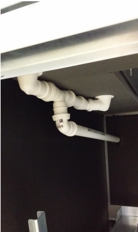
Kuva 9: kondenssivesiputki
