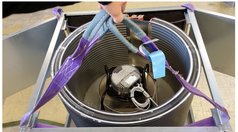
Kuva 10: keskiosan oikea nostaminen
